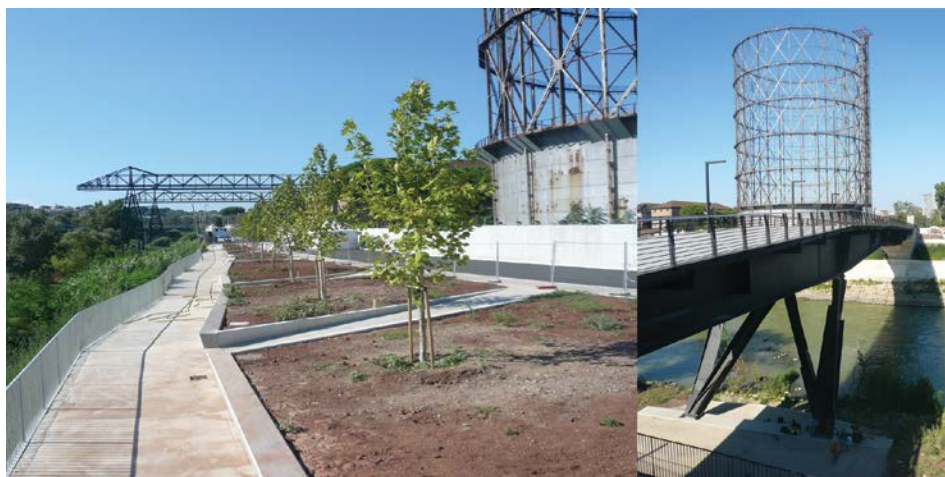
Figura 7. Fotos de 2015 del nuevo boulevard y del puente (Autora).
